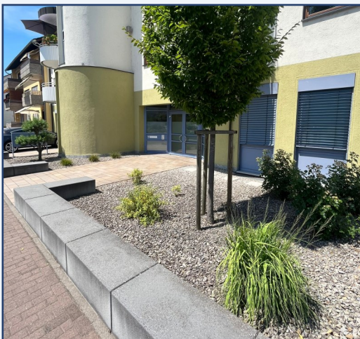
Eingangsbereich Wohngemeinschaft Marktheidenfeld, kostenfreie Parkplätze
